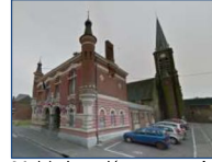
Mairie inondée : pas exploitable dans le pilotage de crise
